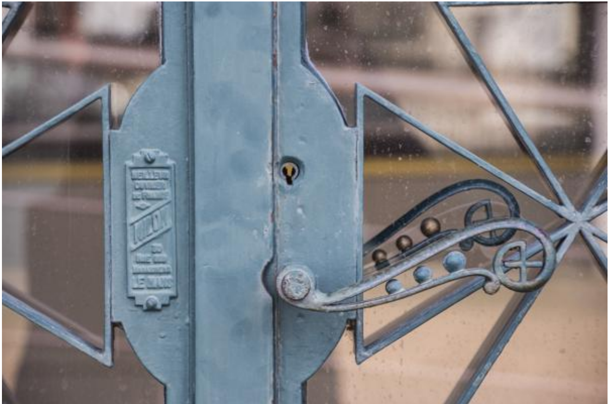
Vue de la poignée de la porte d'entrée.
