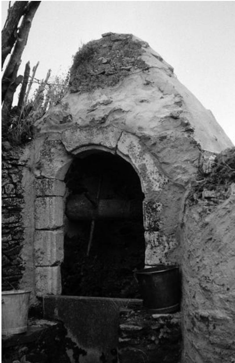
Le Dodineau. "Le Logis". Détail du puits en 1972.
