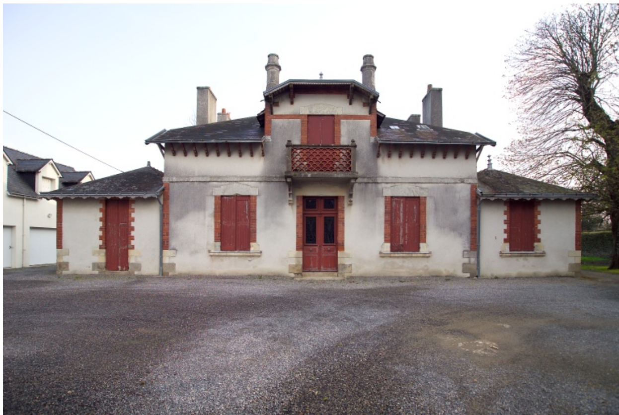
Vue de la façade sur rue.
