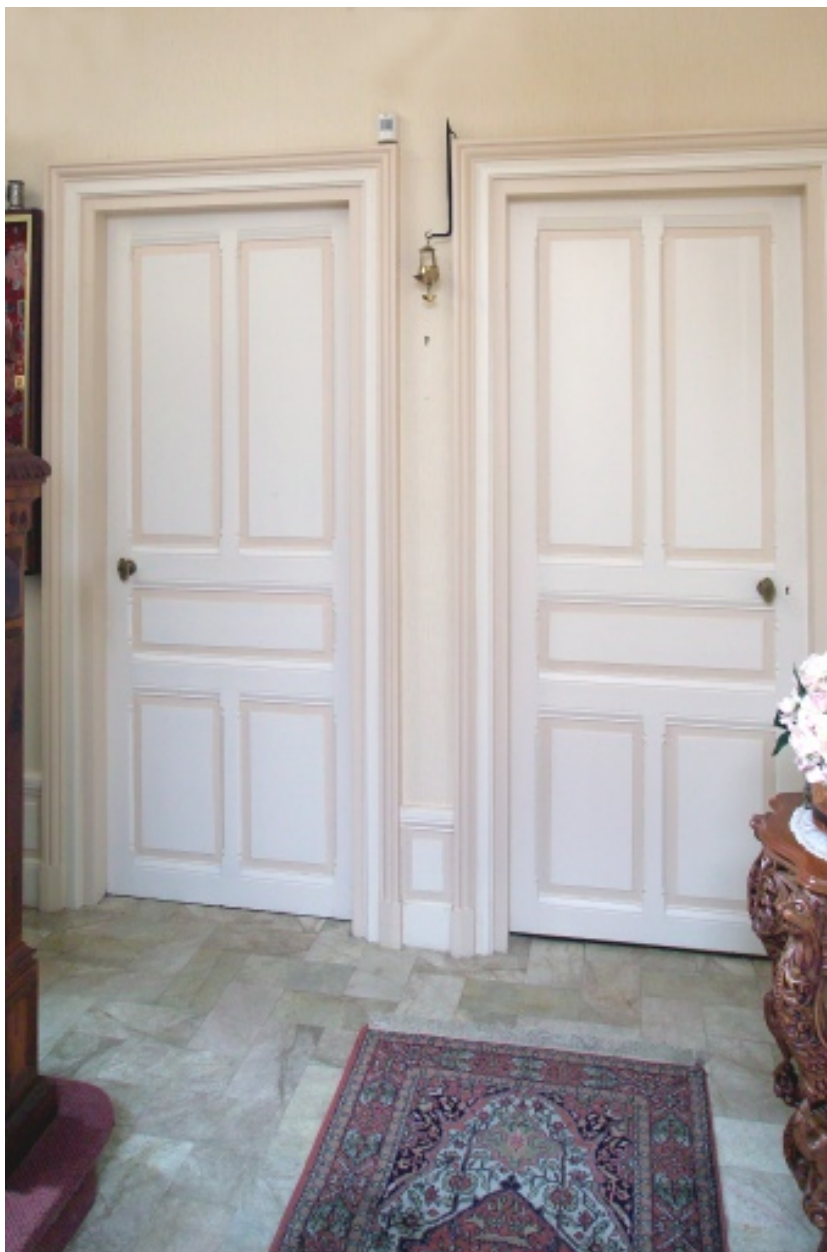
Portes pour l'accès aux salons du rez-de-chaussée.
