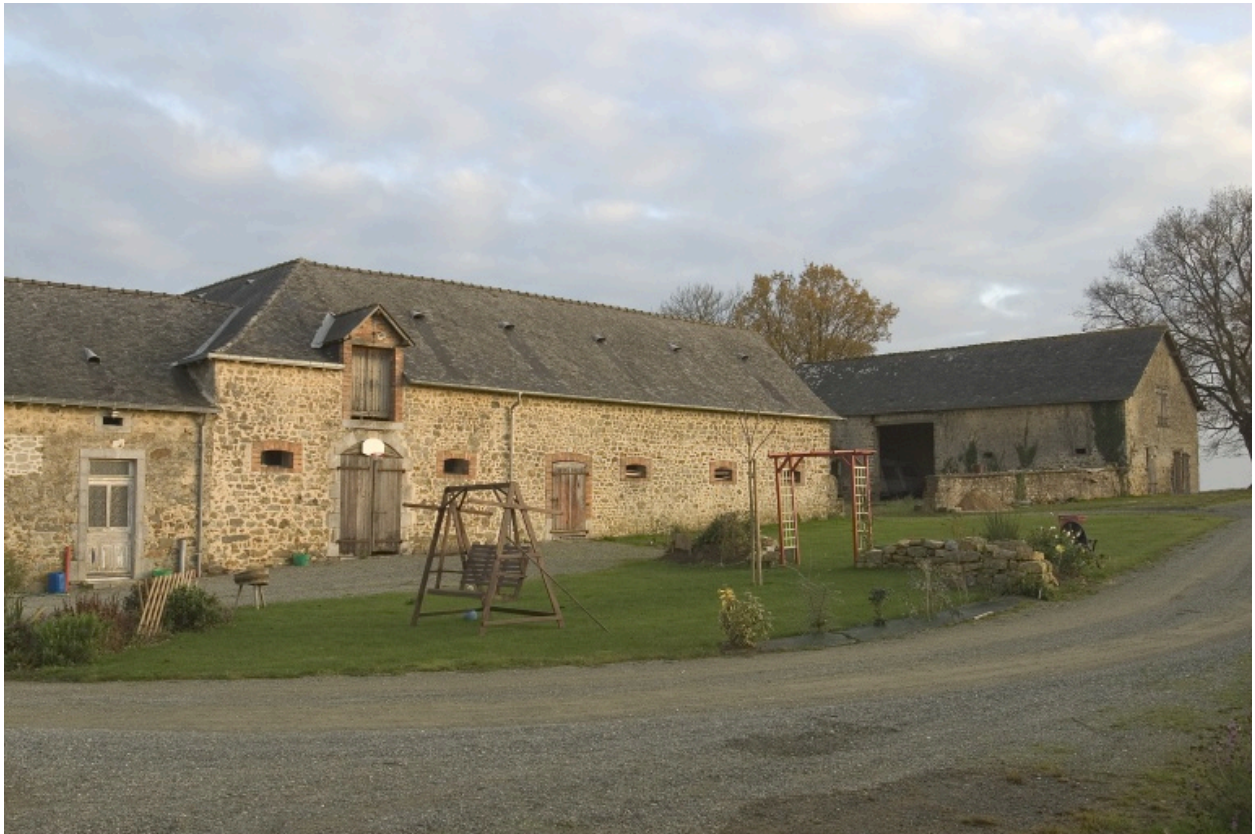
L'étable et la remise vues depuis le nord-ouest.
