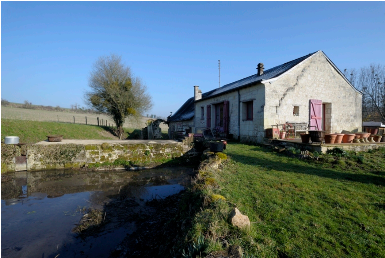
Le moulin et sa retenue d'eau.
