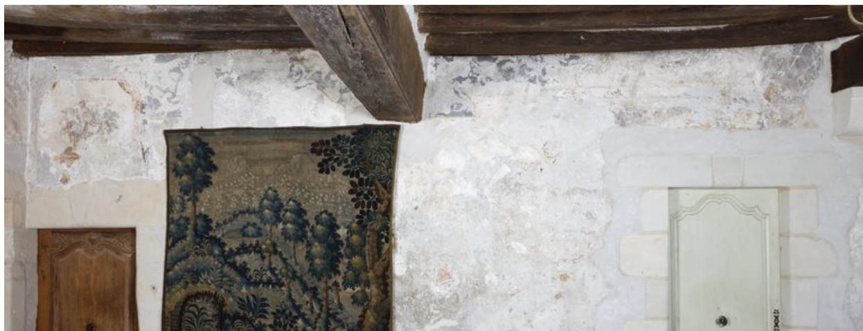
Rez-de-chaussée, salle, mur postérieur : vue d'ensemble du premier décor peint.
