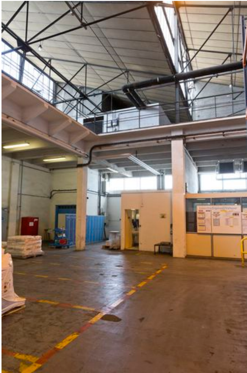
Charpente métallique du magasin général construit entre 1960 et 1956.
