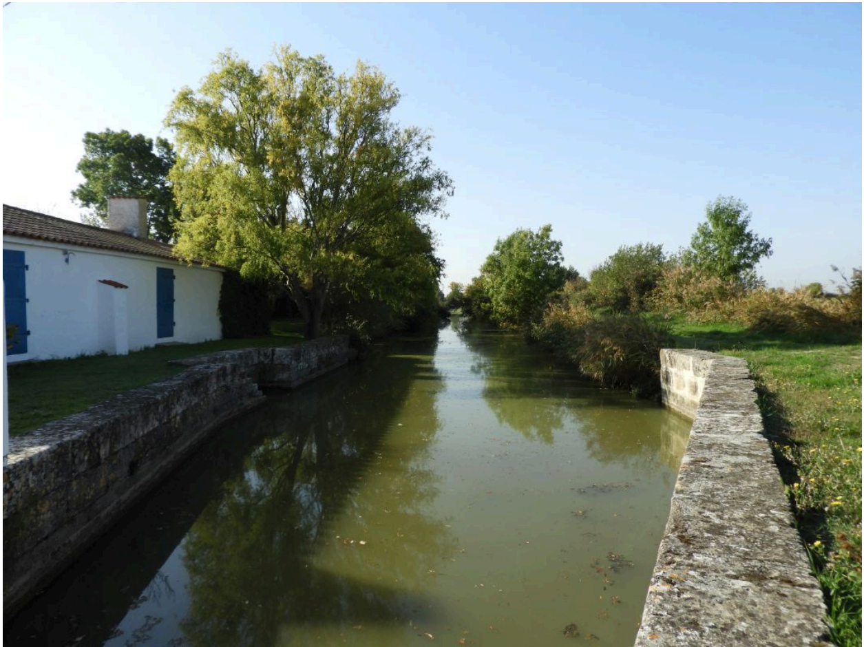
Le départ du canal du Clain, à la bonde du Coteau, en direction du sud.
