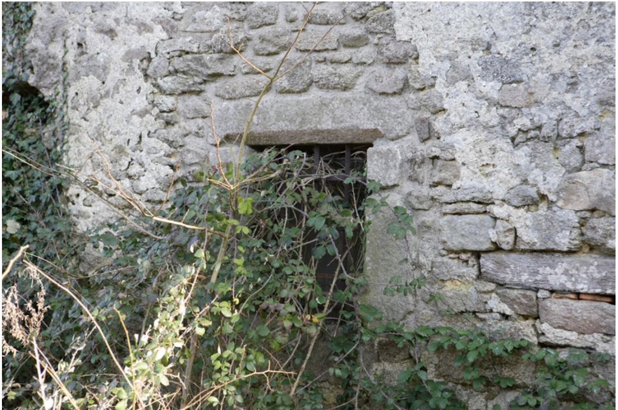
Aile ouest. Salle basse. Détail de la fenêtre sur le mur goutterau nord.
