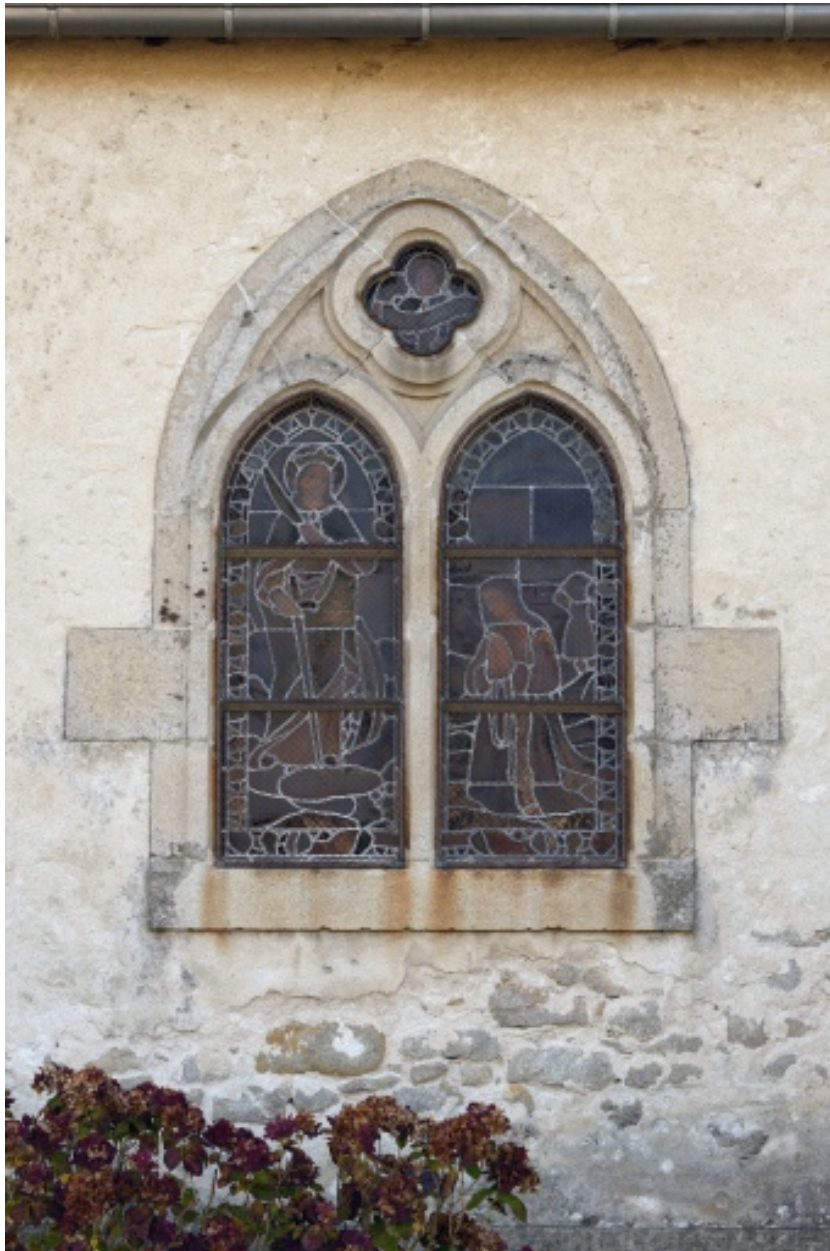
Détail de la baie géminée nord.
