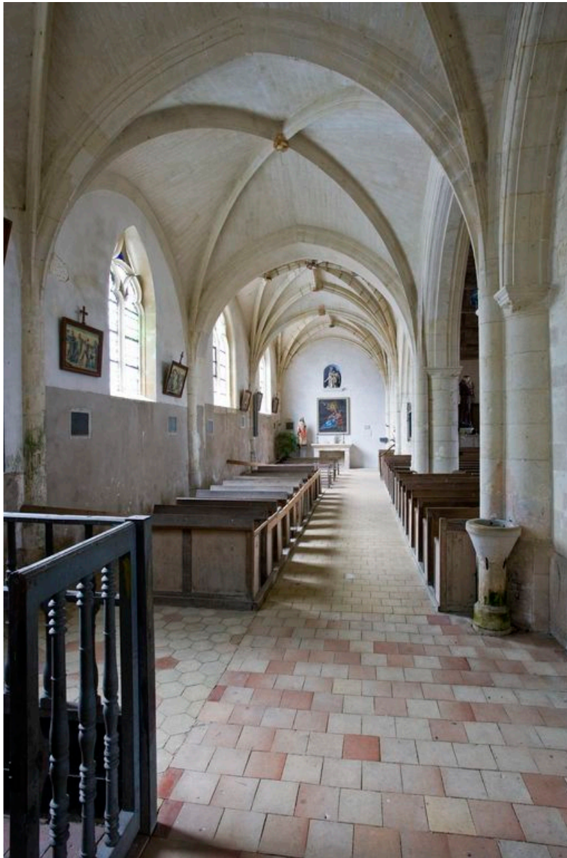
Bas-côté nord, vu depuis l'ouest
