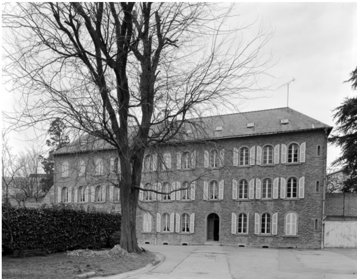
Cour postérieure, bâtiment nord isolé.
