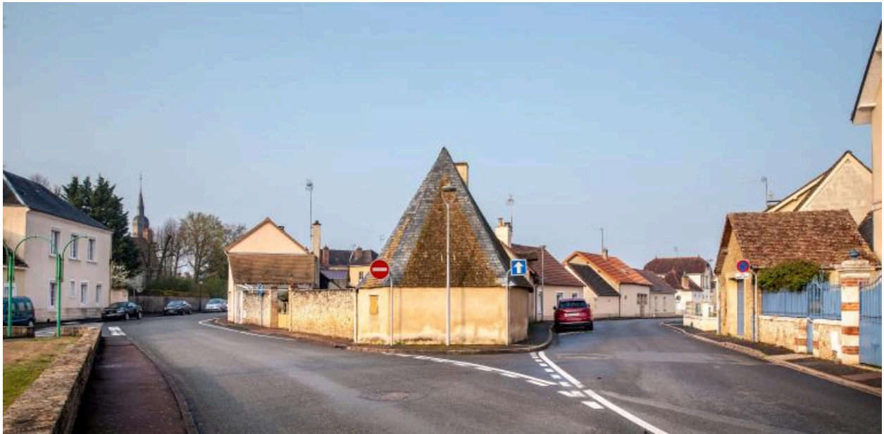
Les rues des Dames et de La Ferté et maison frappée d'alignements au centre.
