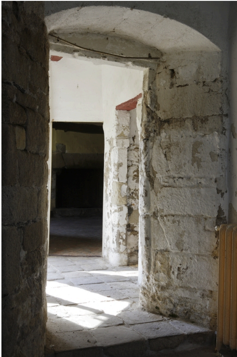
Aile est. Détail de l'ancienne croisée transformée en porte.
