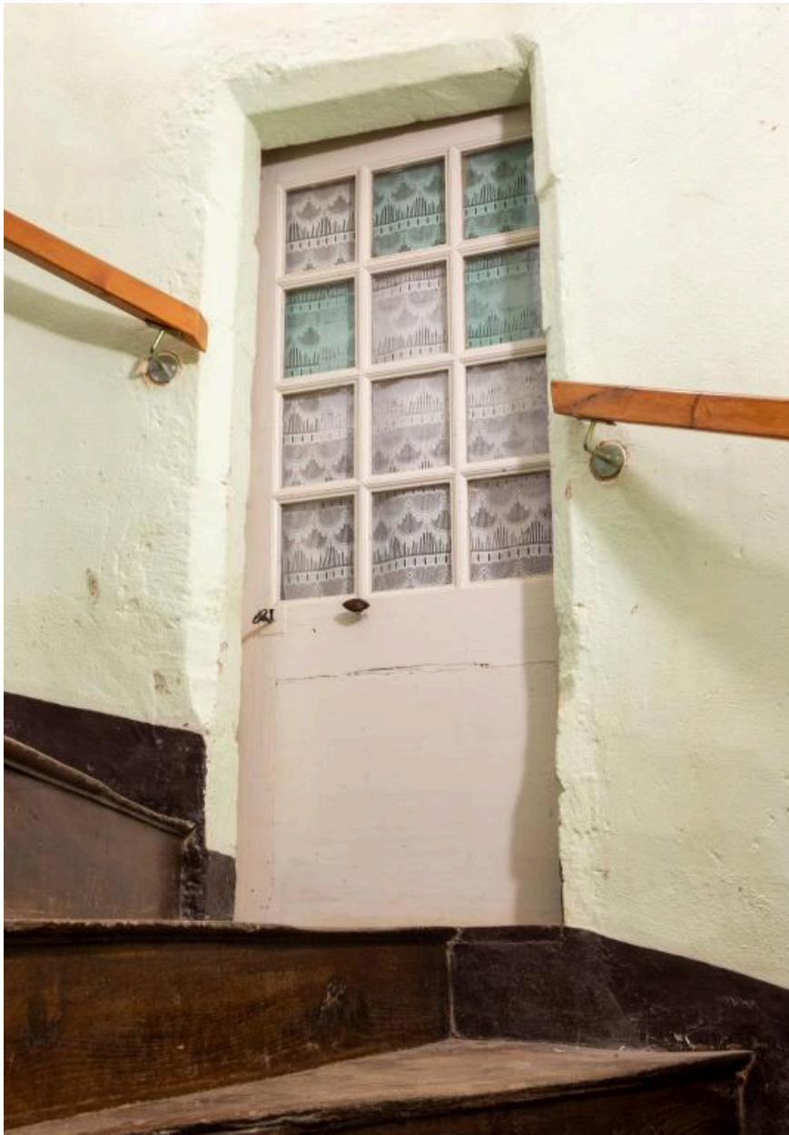
Une porte chanfreinée dans l'escalier.
