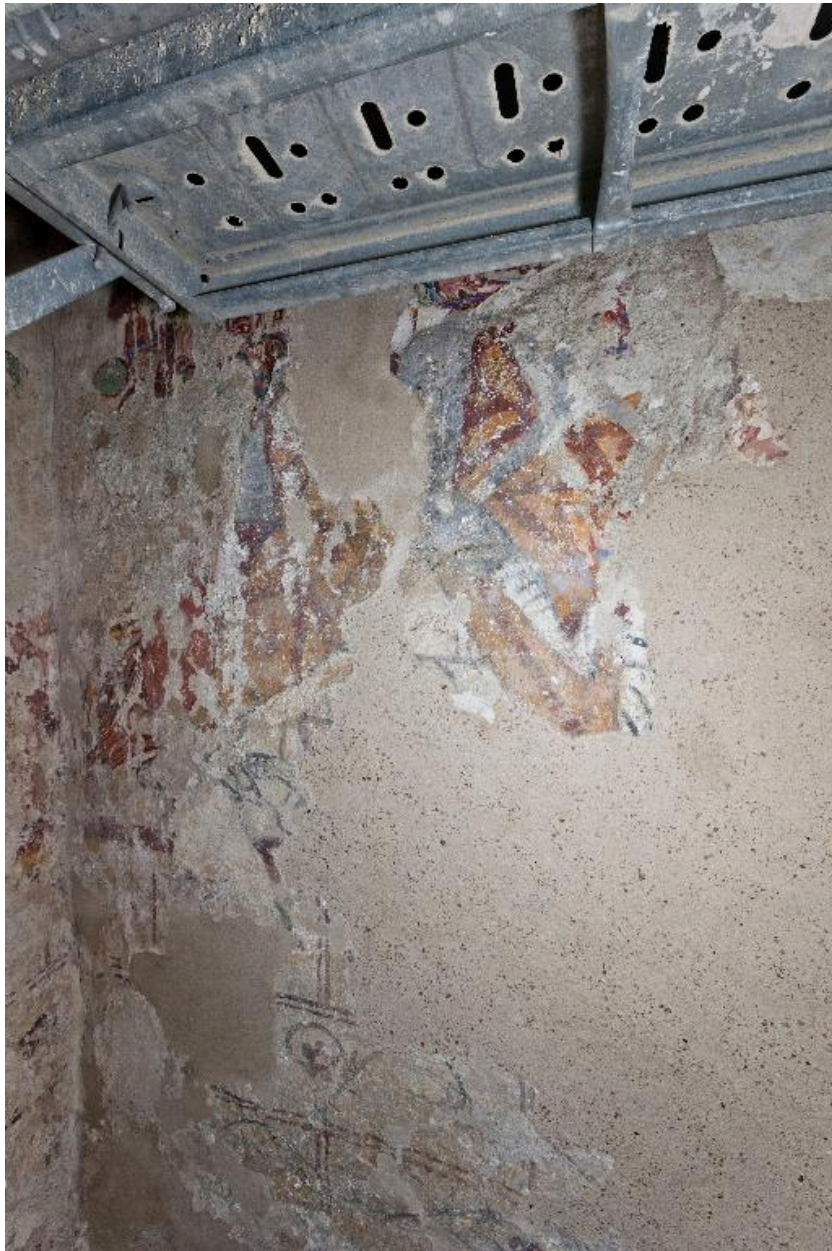
Bras nord du transept, mur est, côté nord. Couche picturale avec des cavaliers recouvrant le décor des années 1200.
