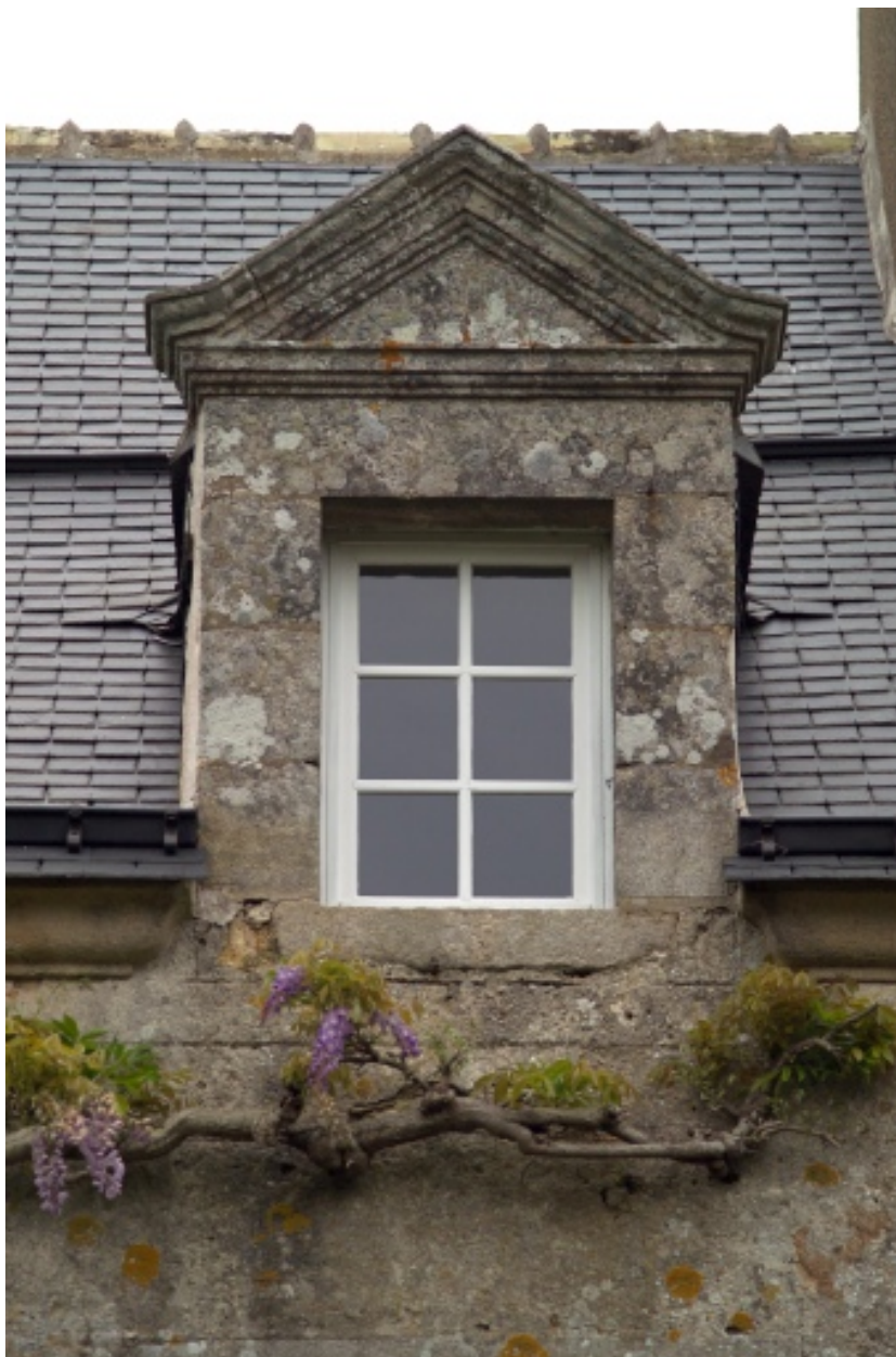
Hôtel XVIIIe siècle, détail d'une lucarne à fronton triangulaire de la façade postérieure.
