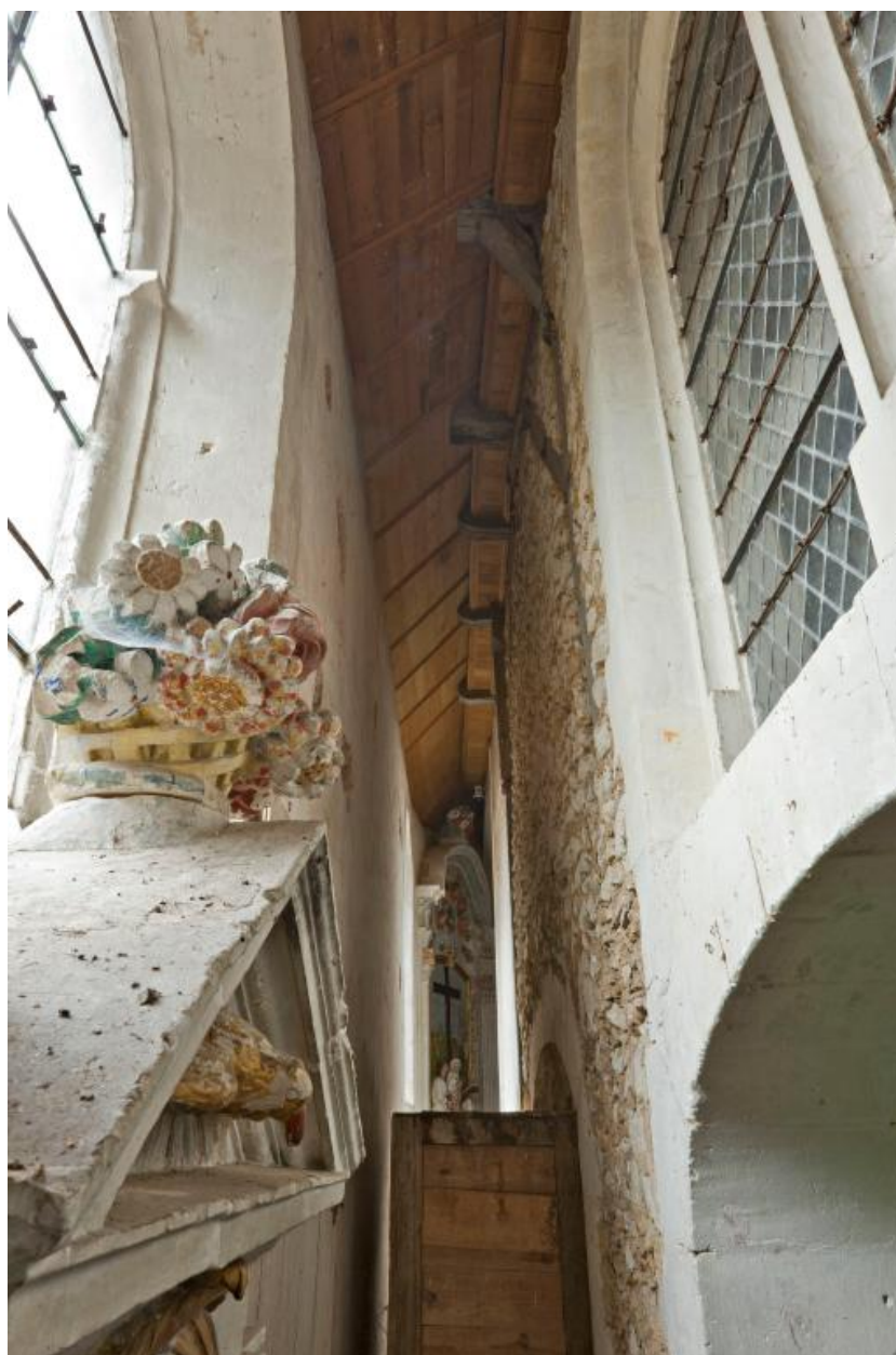
Nef : dédoublement du mur nord, vu depuis l'ouest.
