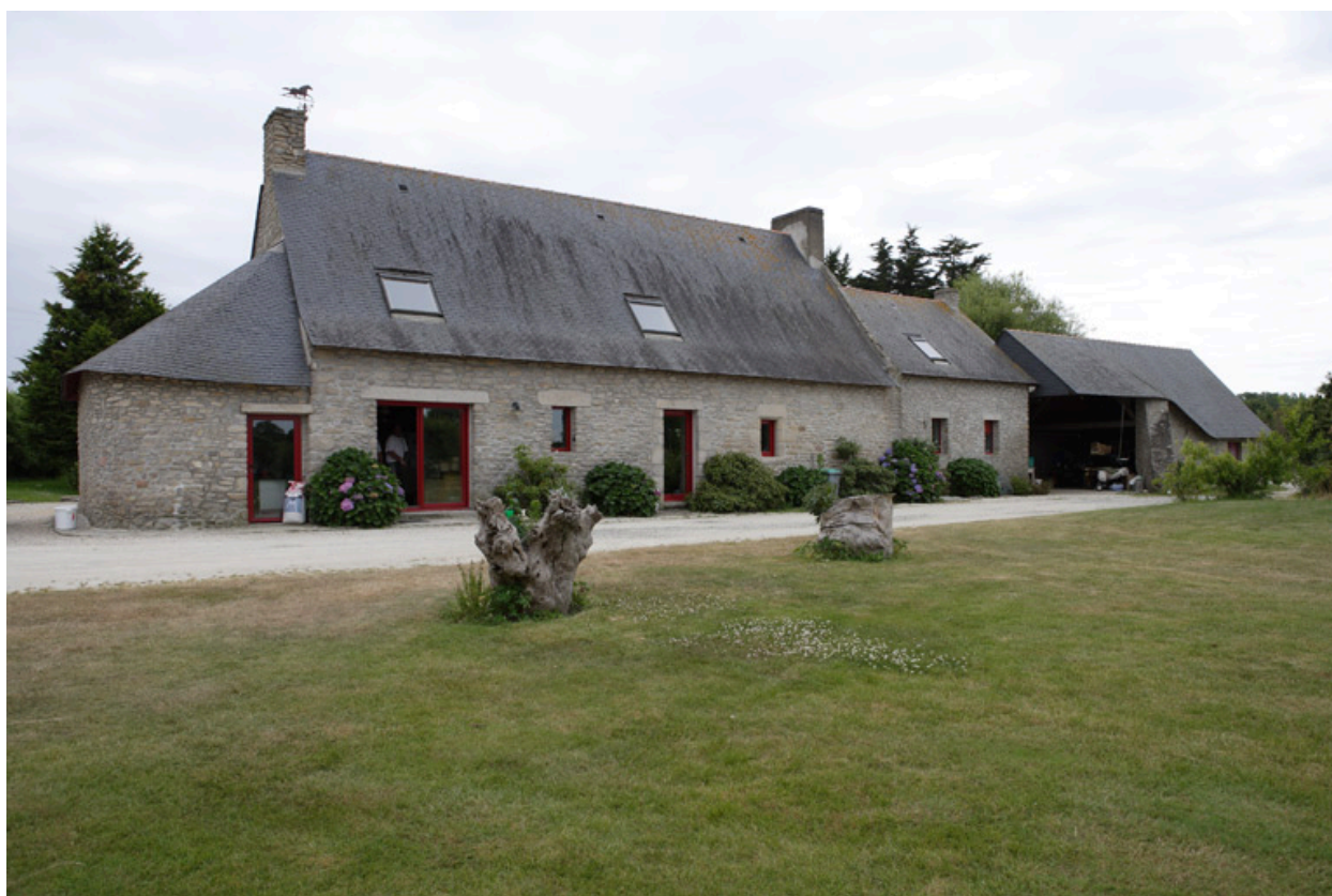
Logis. Façade nord.
