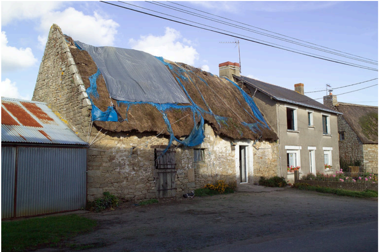
Vue d'ensemble de la rangée d'habitation depuis le sud-ouest.
