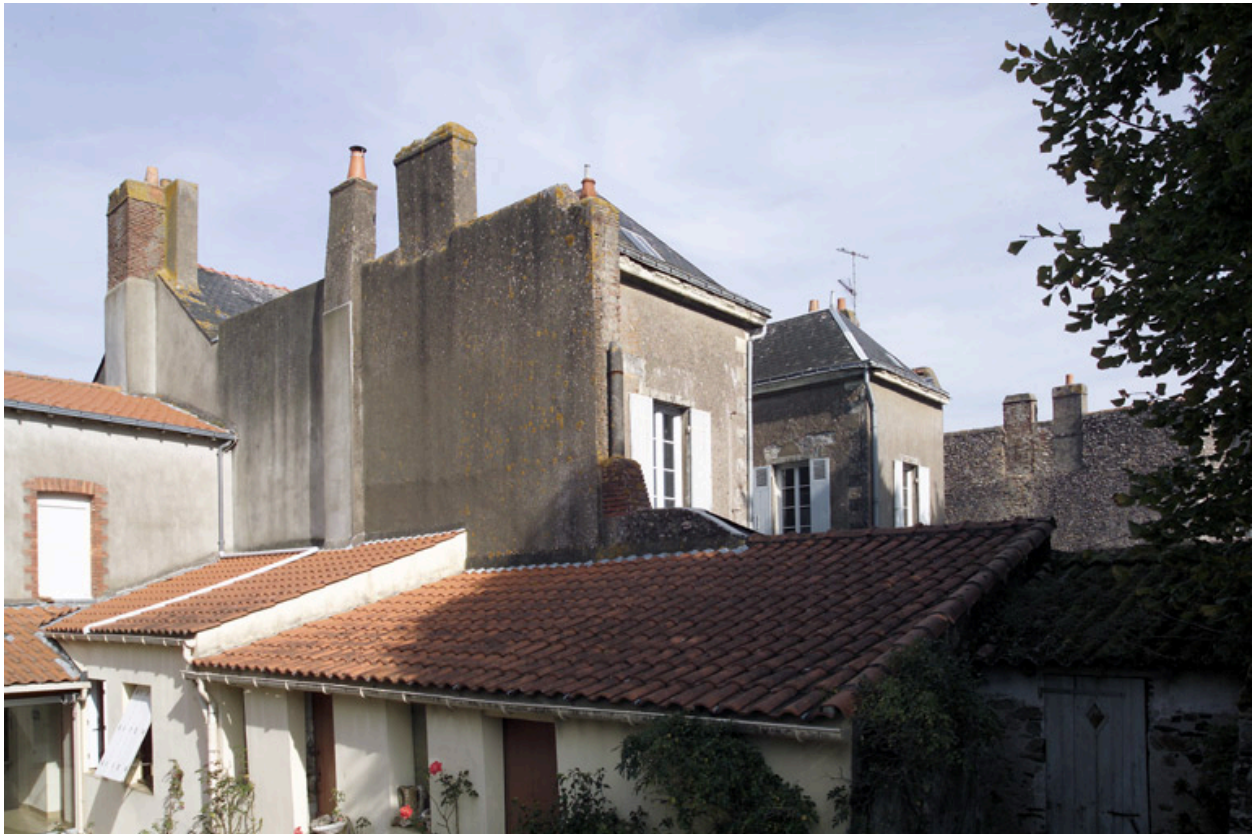
Les deux corps secondaires vus depuis la cour de la maison n° 29 quai Eole.
