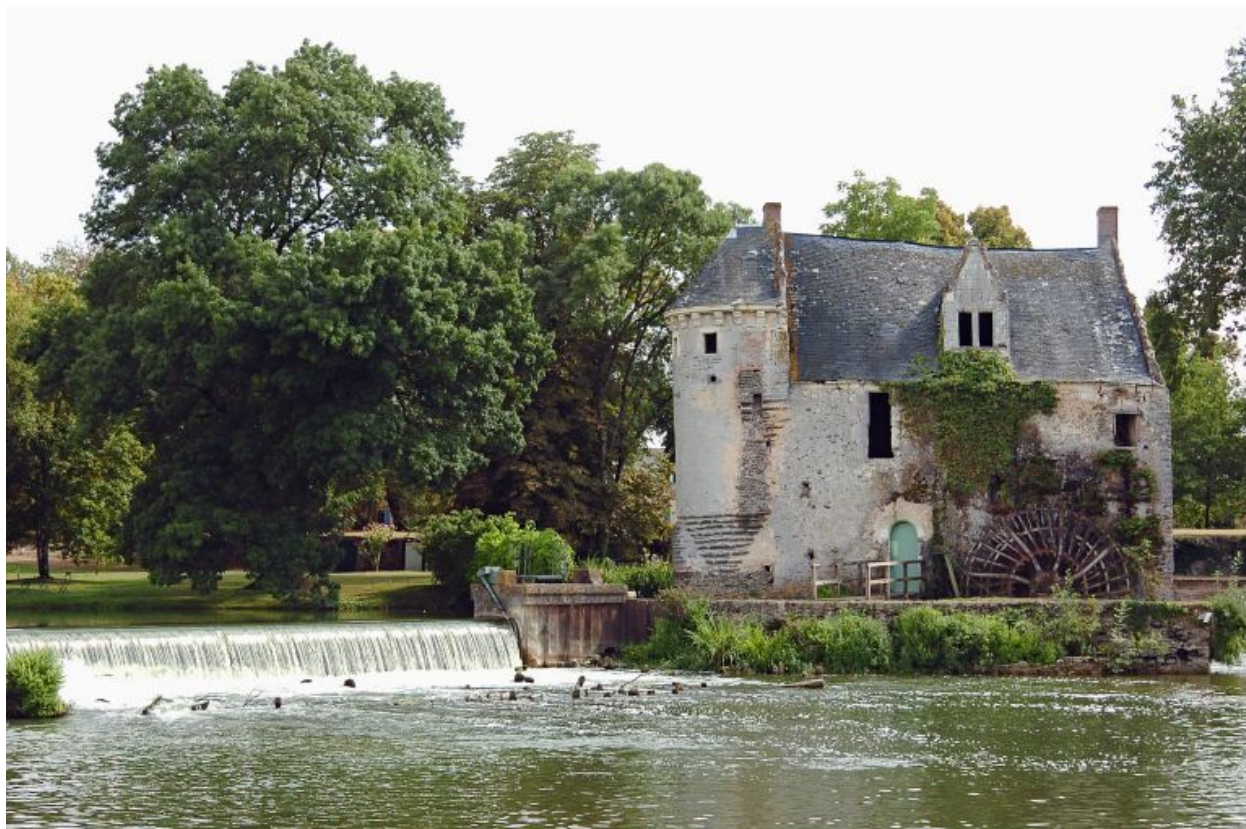
Vue d'ensemble prise de la rive droite du Loir.
