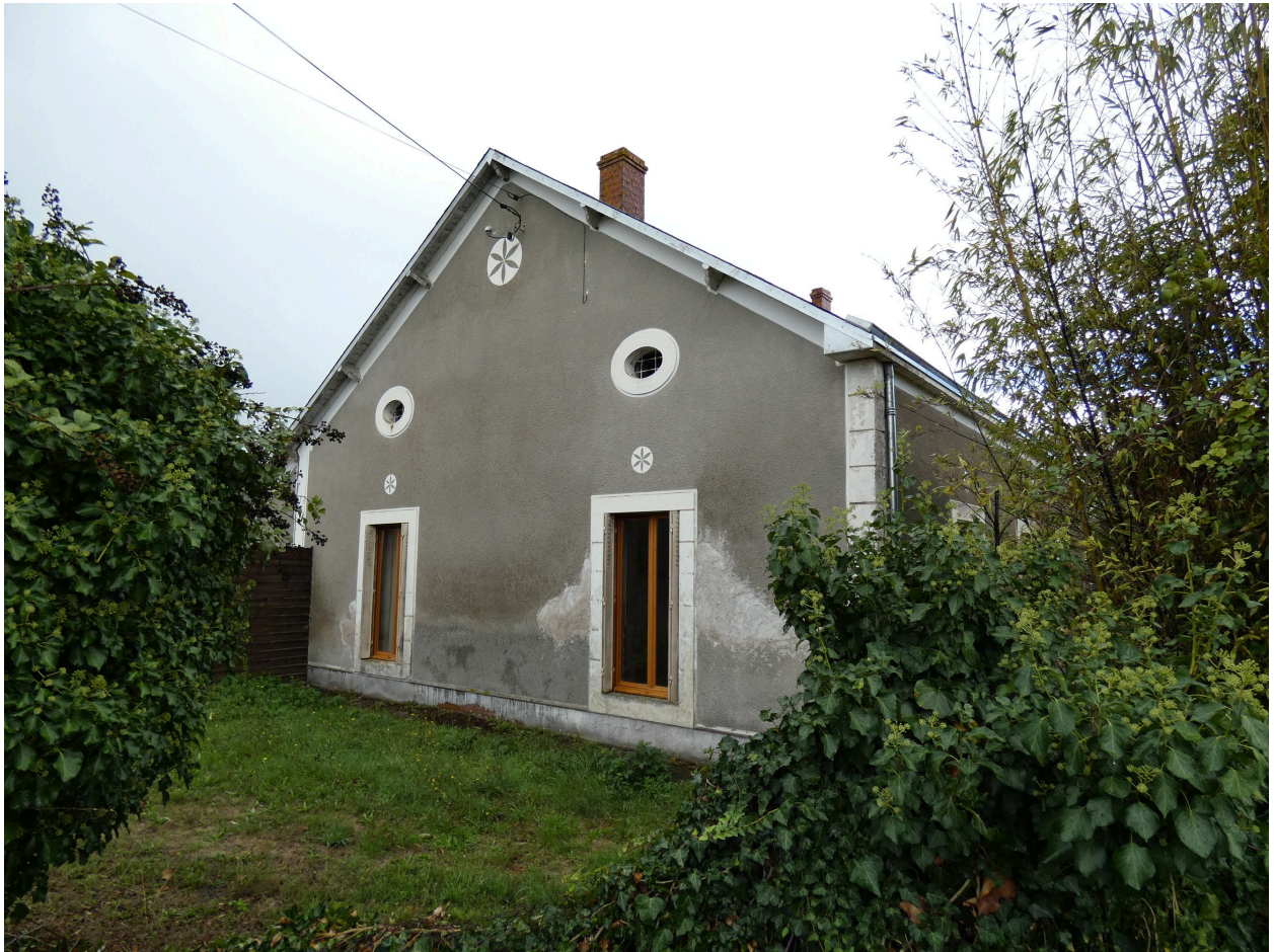
Le logement de directeur, à l'est de l'ensemble, vu depuis le nord-ouest.
