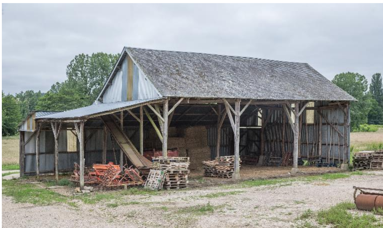
Hangar agricole à structure en bois.
