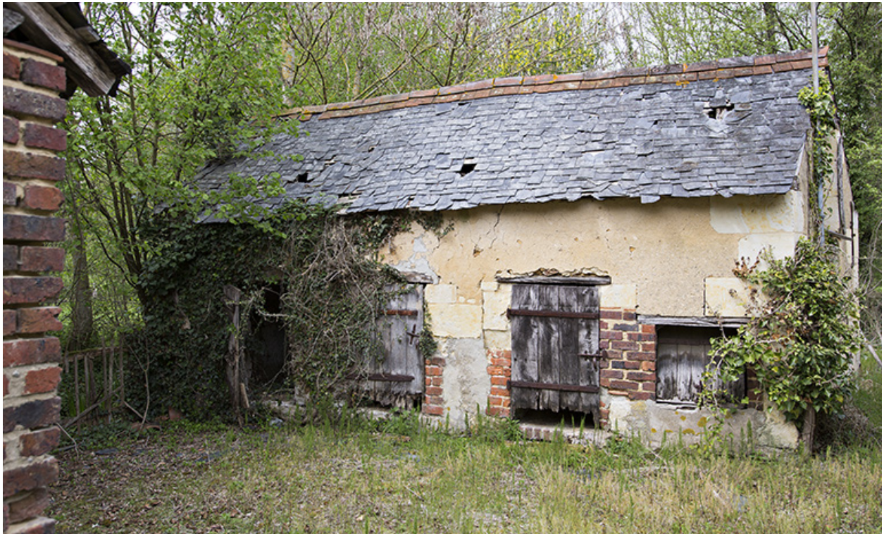
Toit à porcs à l'arrière du logis.
