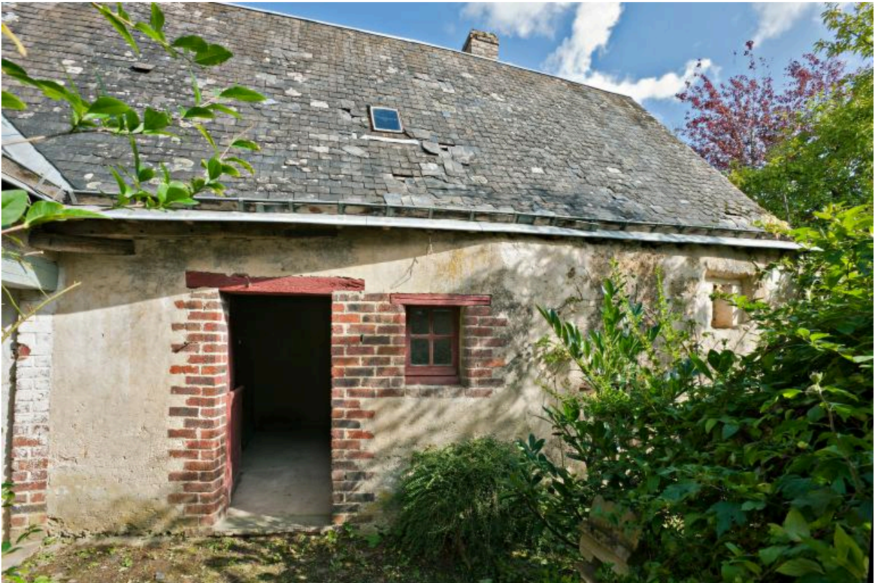
Maison 2 : façade antérieure sur jardin.
