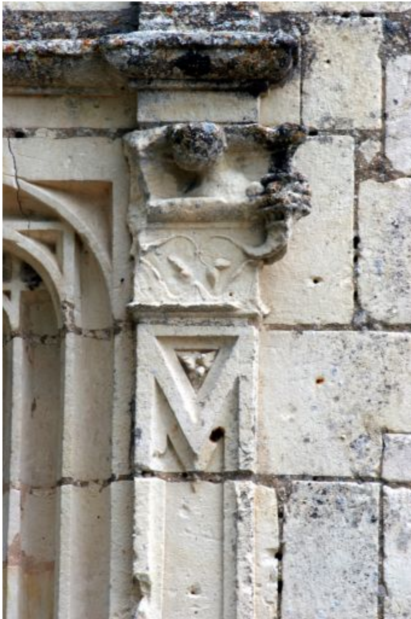
Le logis, baie du rez-de-chaussée : chapiteau 2.
