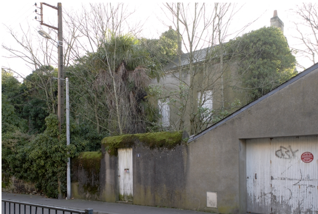
Logement pour le personnel (?), rue des Réformes.
