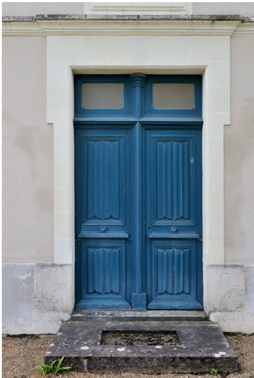
Façade principale (sud) : porte.
