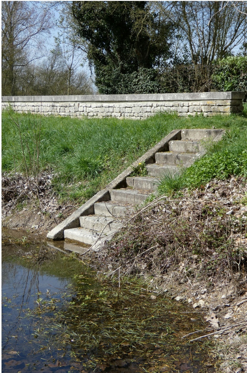
Escalier descendant au bassin du port sur sa rive nord.
