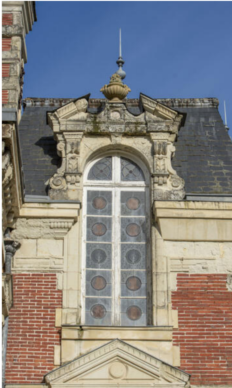
La cage d'escalier, détail d'une fenêtre.
