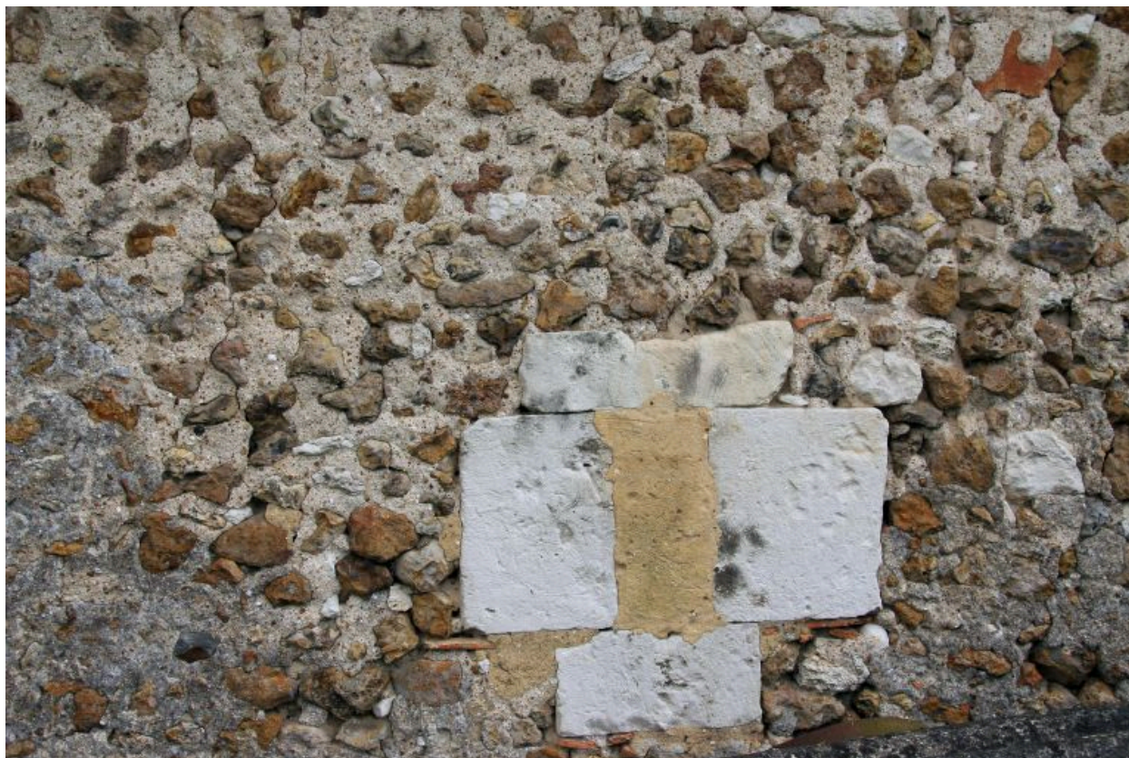
Les étables, détail des matériaux : rognons de silex enduit.
