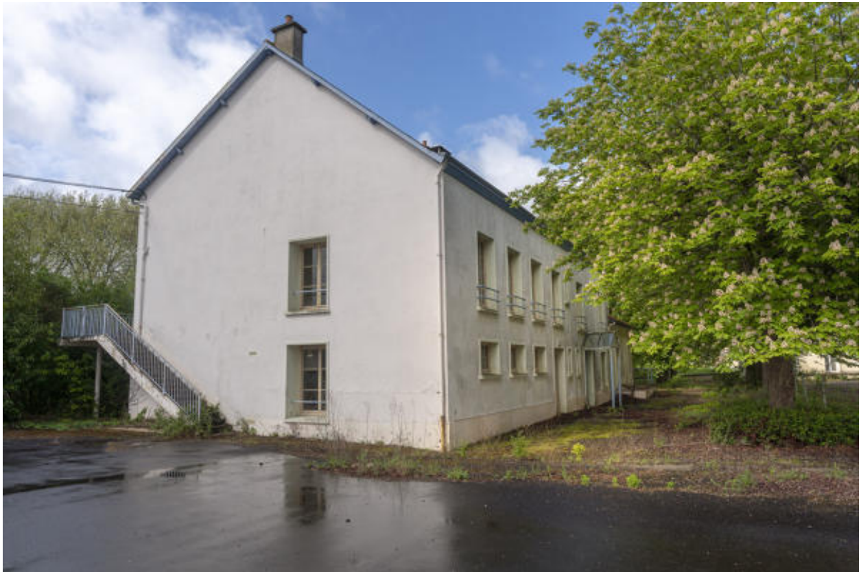
Pignon du bâtiment E.
