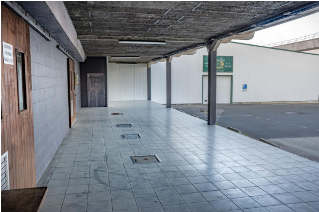
Quai de déchargement des vins ; trappes des cuves enterrées nord.
