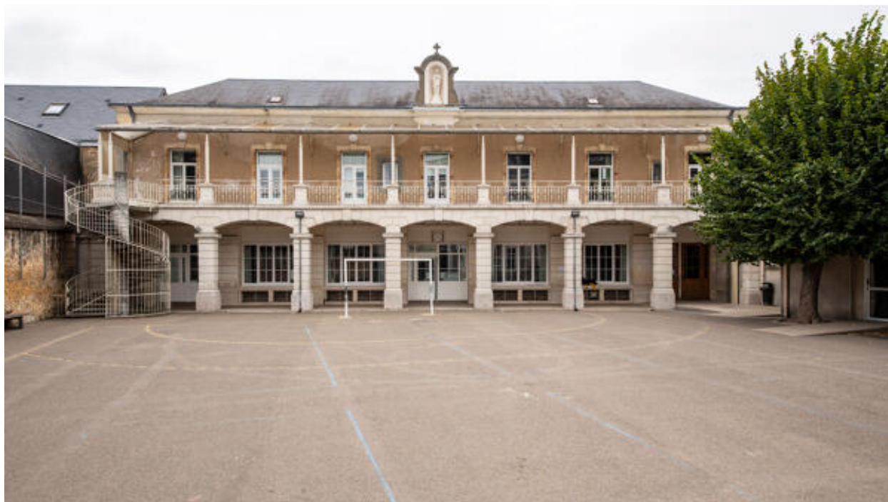
Vue du bâtiment en fond de cour.
