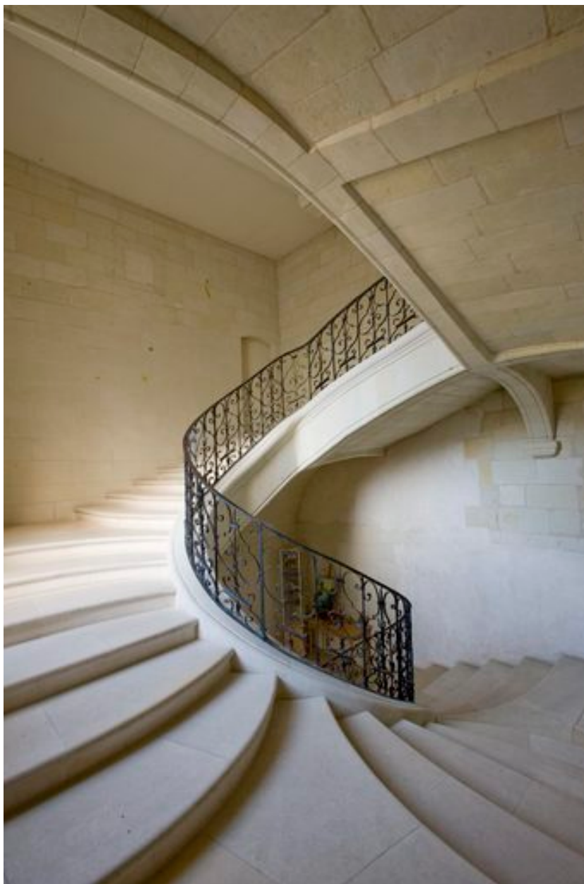
Prieuré Saint-Lazare, escalier tournant à jour (après restauration).
