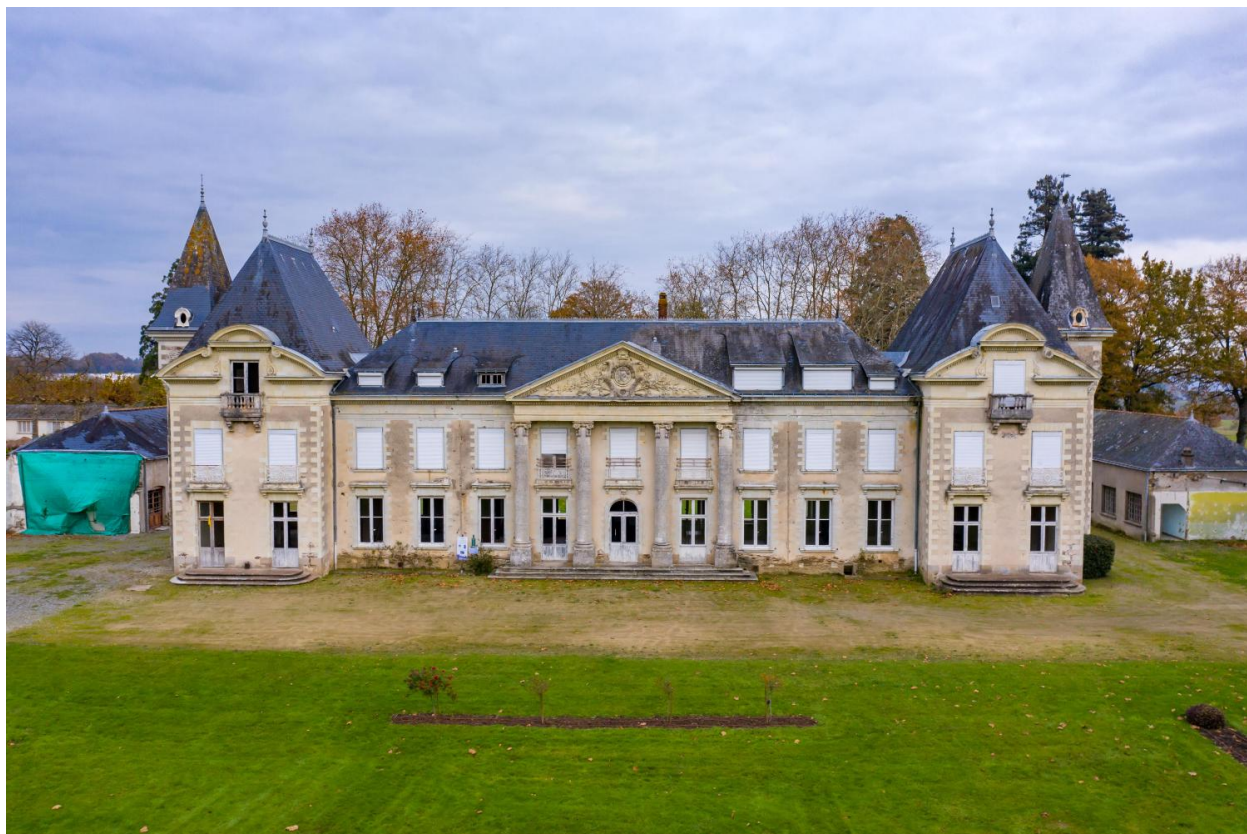
Élévation postérieure du logis.
