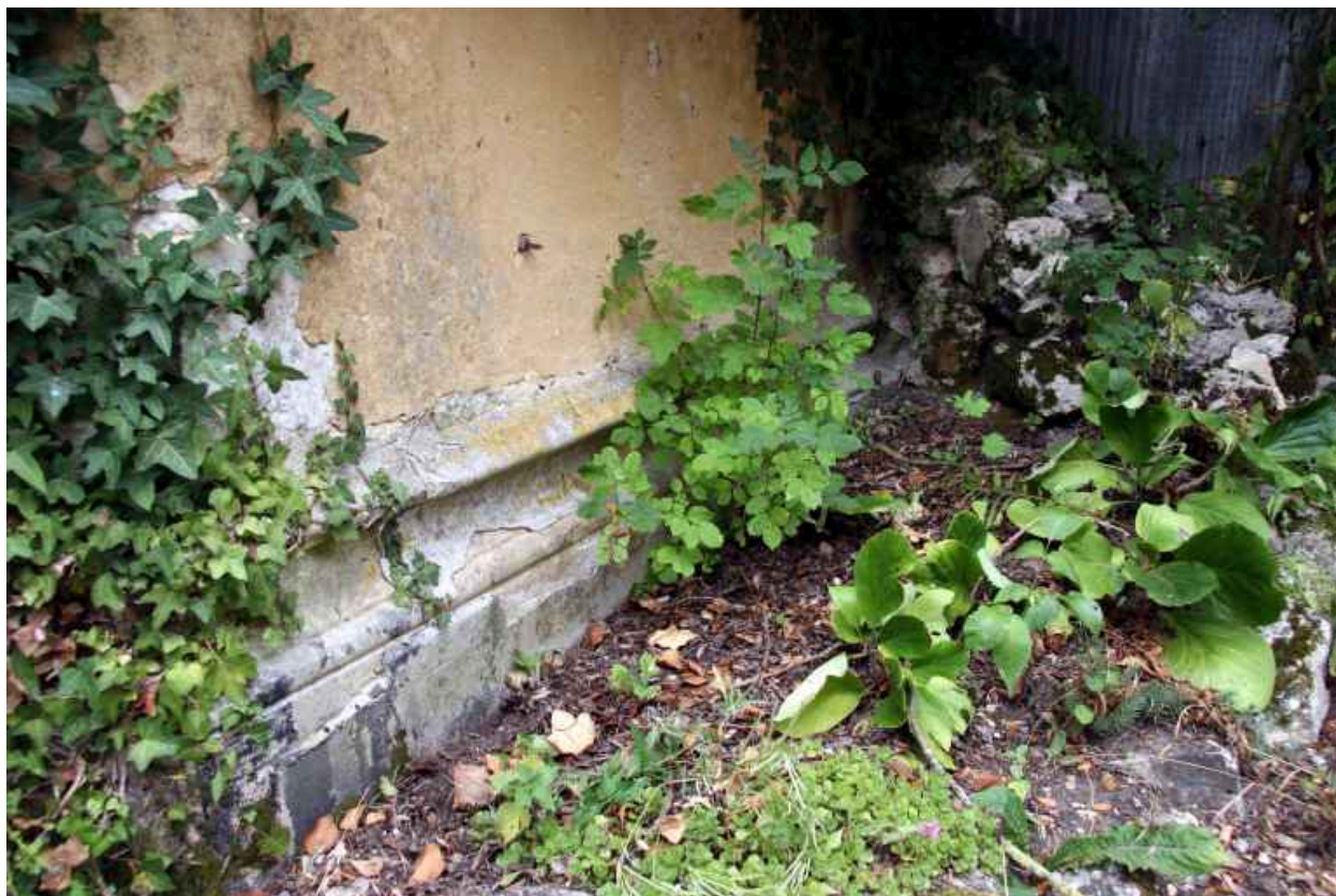
Pierre de soubassement en place.
