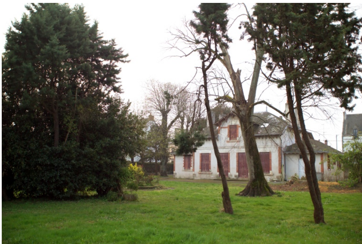
Vue de la façade arrière.
