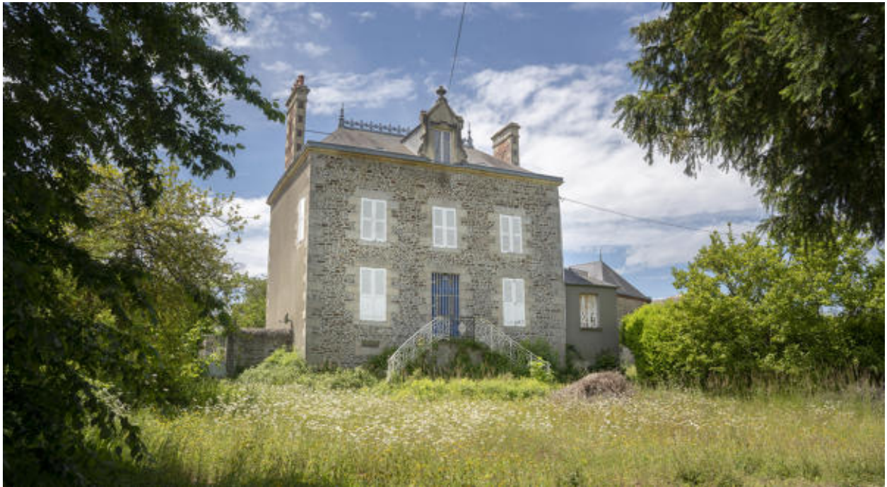
La façade antérieure de la maison.
