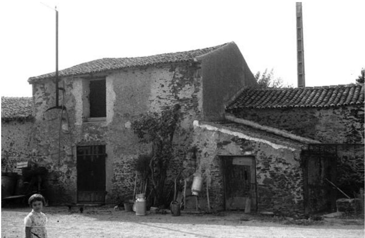
La Commazière. Vue du logis de la ferme et de l'étable prise lors du pré-inventaire en 1972.
