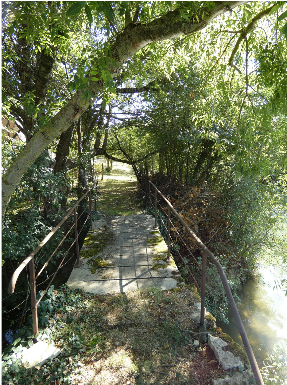
La passerelle de halage à l'entrée du port, vue depuis le nord.
