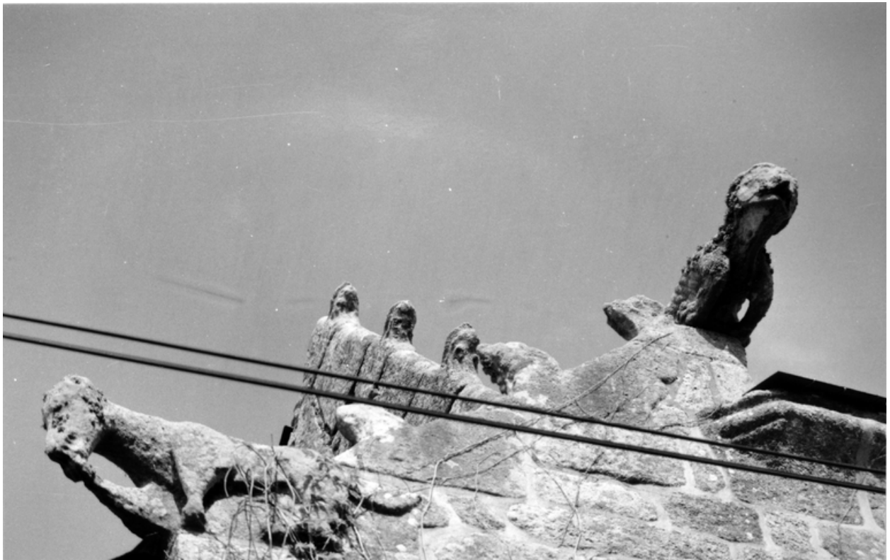
Logis. Détail des crossettes sculptées sur le pignon ouest. 1990.
