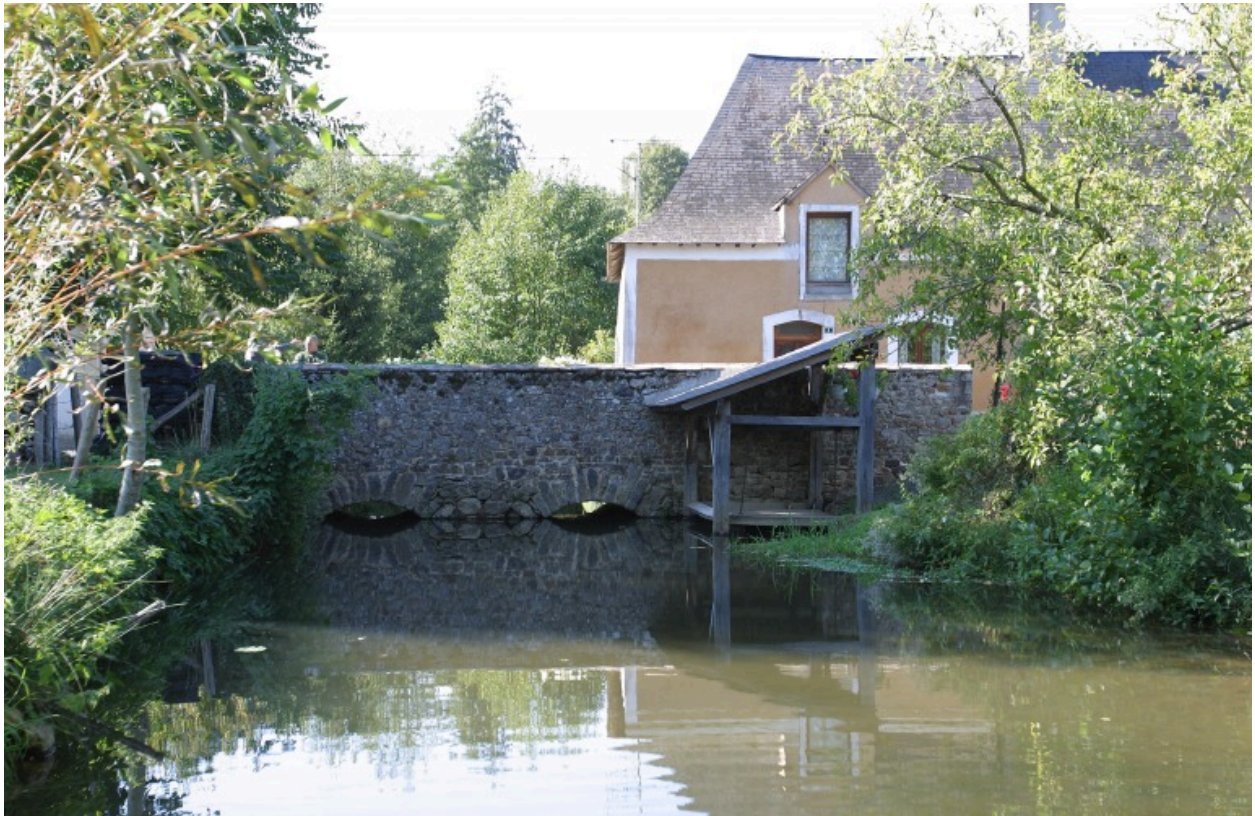
Le pont et le lavoir vus depuis l'est.
