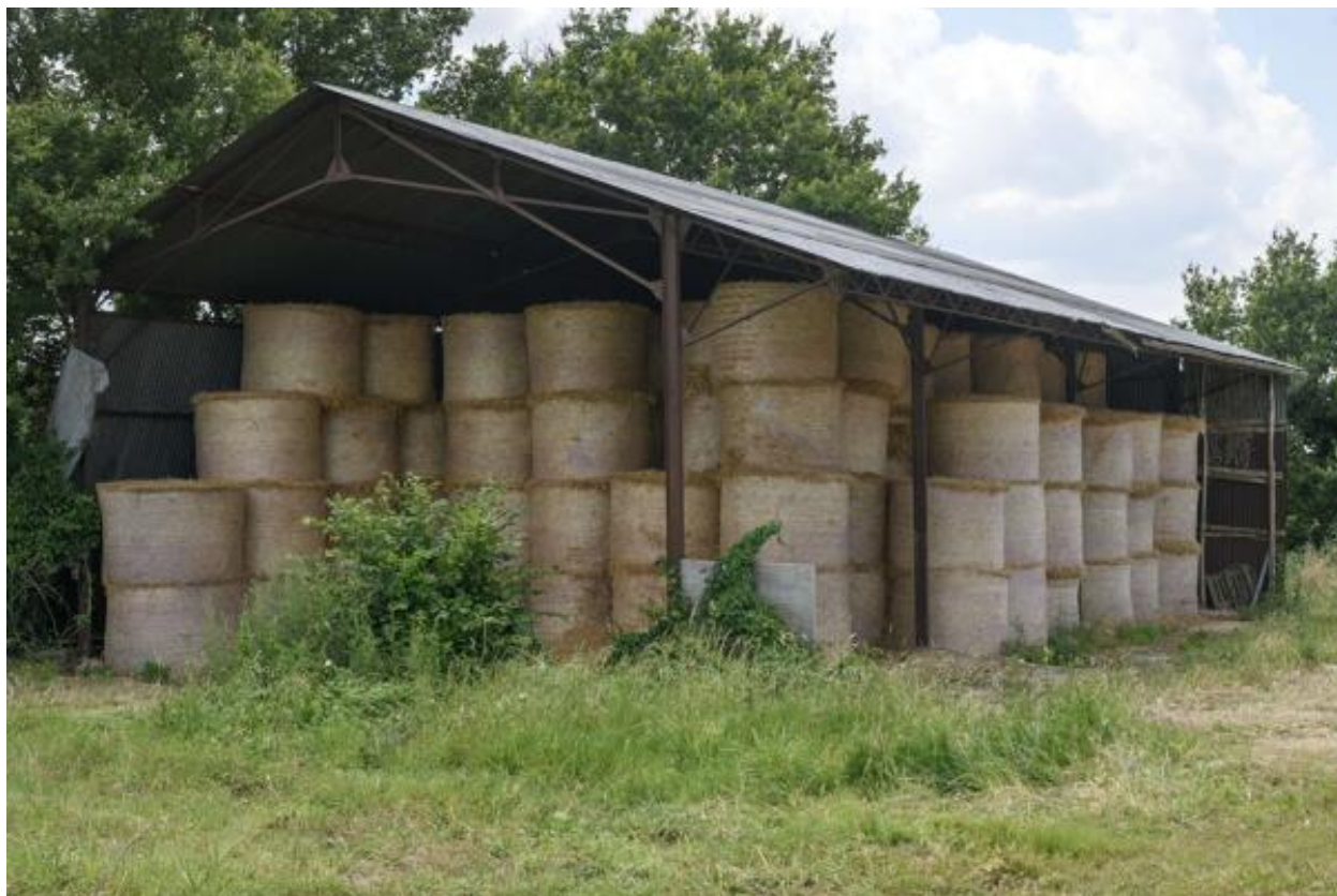
Vue du hangar agricole.
