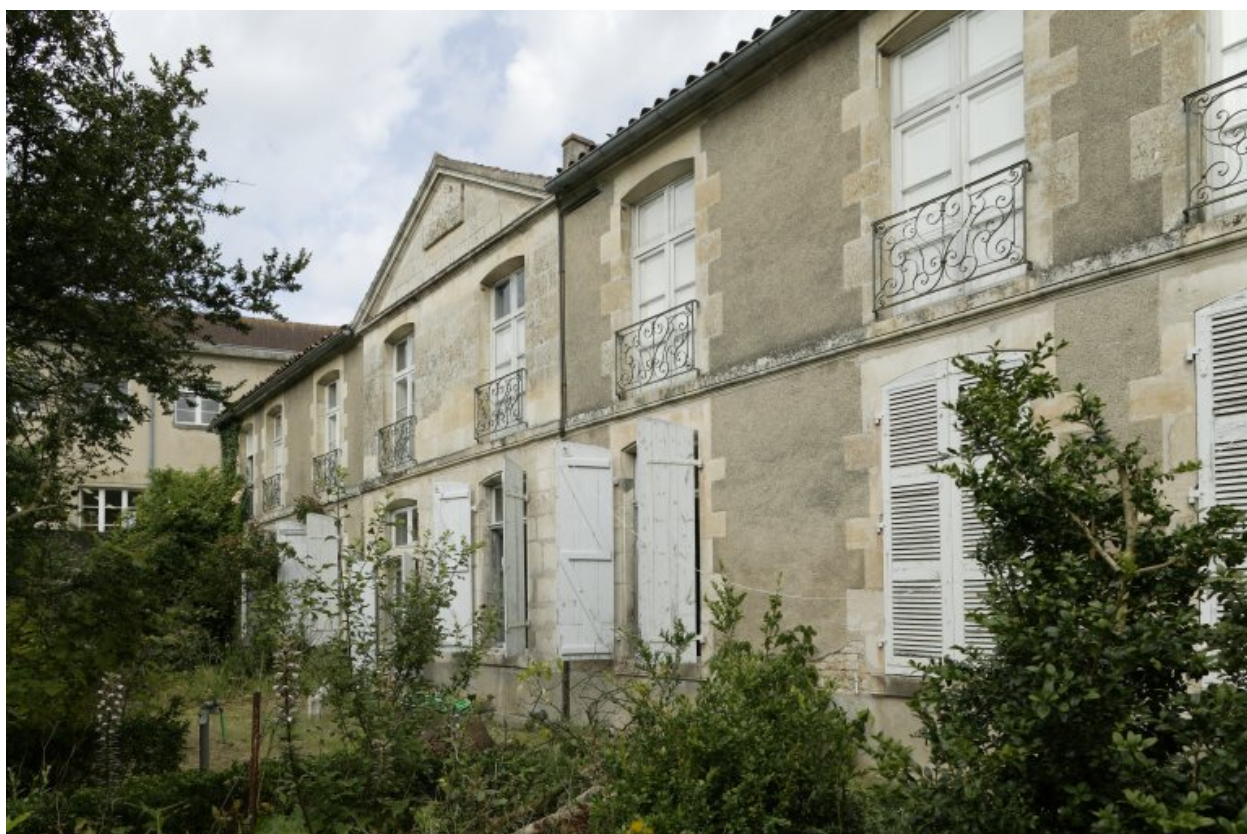
Façade sur jardin du bâtiment principal.
