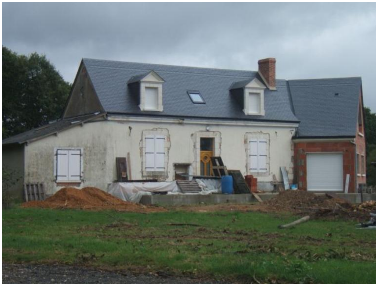
Les Forges : façade antérieure sur cour.
