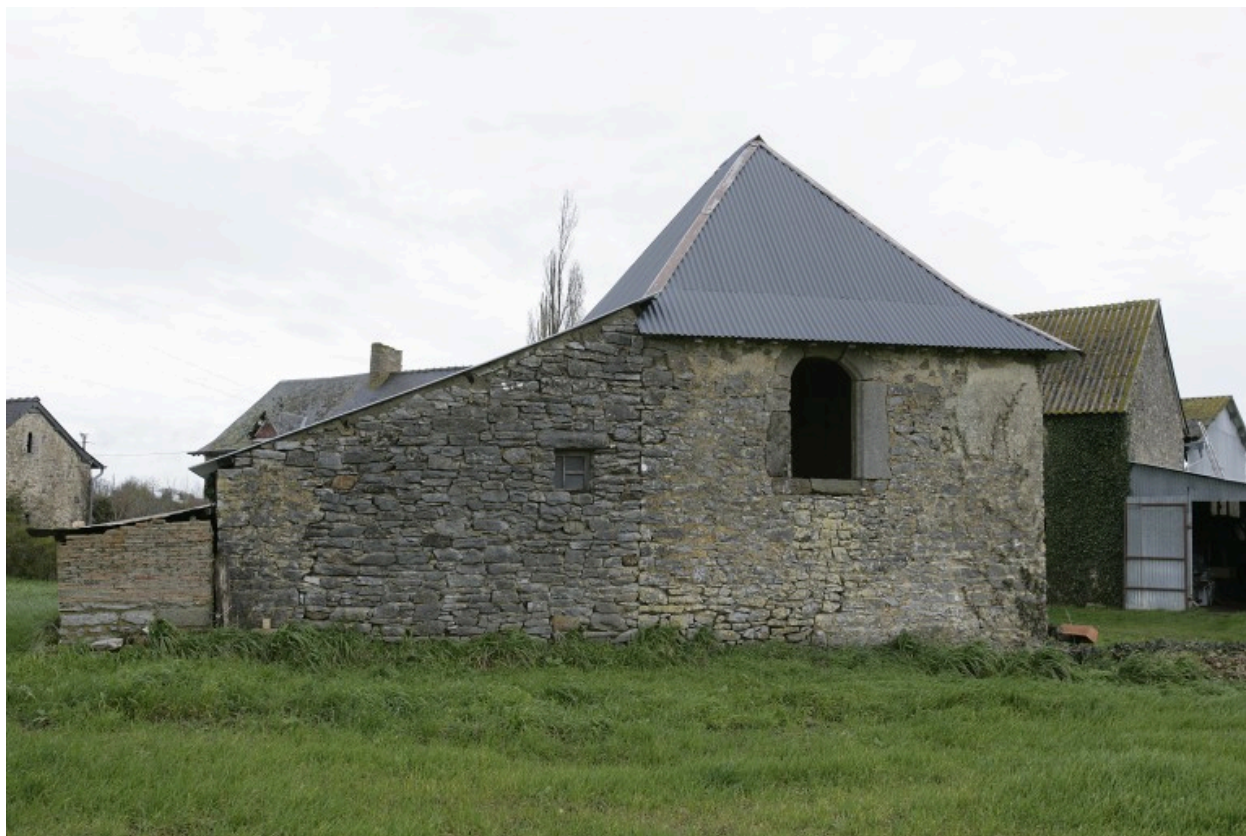
La chapelle vue depuis le sud.
