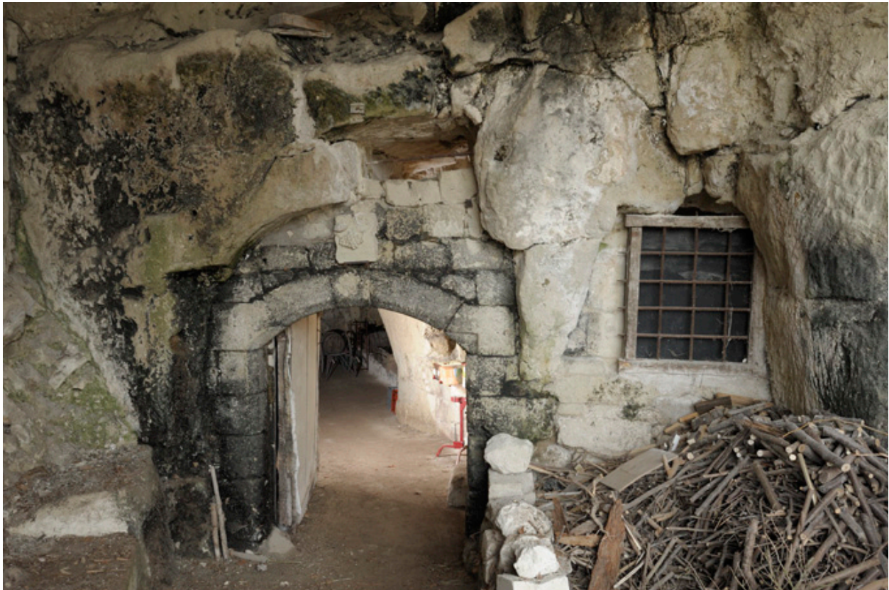
Abri troglodytique au sud-est de la cour (attesté début XVIe siècle) : porte chanfreinée à arc segmentaire.
